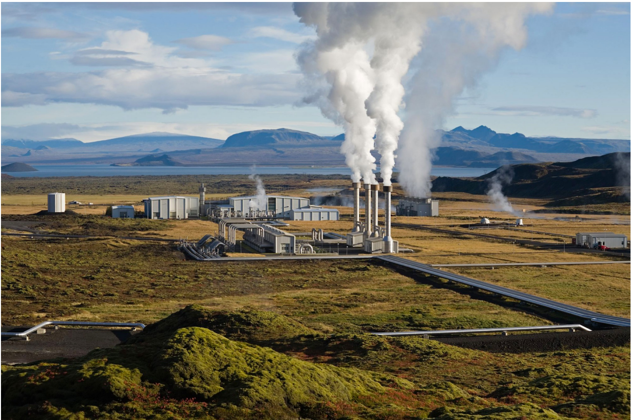
Abb. 6: Das nahe Þingvellir gelegene Nesjavellir-Kraftwerk ist das größte Geothermalkraftwerk Islands. Es stellt 120 MW an elektrischer und 300 MW an thermischer Energie bereit ( https://de.wikipedia.org/wiki/Nesjavellir-Kraftwerk ), das aber seit 1990 mit dieser Leistung nur für etwa 30 Jahre, danach nahm die Leistung kontinuierlich ab. Mit dieser elektrischen Leistung könnte nur soviel CO 2 der Luft entzogen und in der Erde endgelagert werden, wie ein 20 MW kleines konventionelles Kraftwerk an CO 2 erzeugt.
