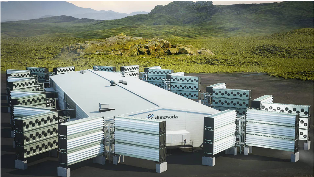
Abb. 5 Die CCS-Anlage „Mammoth“ der Firma Climeworks, die seit 2022 auf Island errichtet wird; sie soll eine Kapazität von 36.000 t CO 2 pro Jahr haben (© Climeworks 2022).
